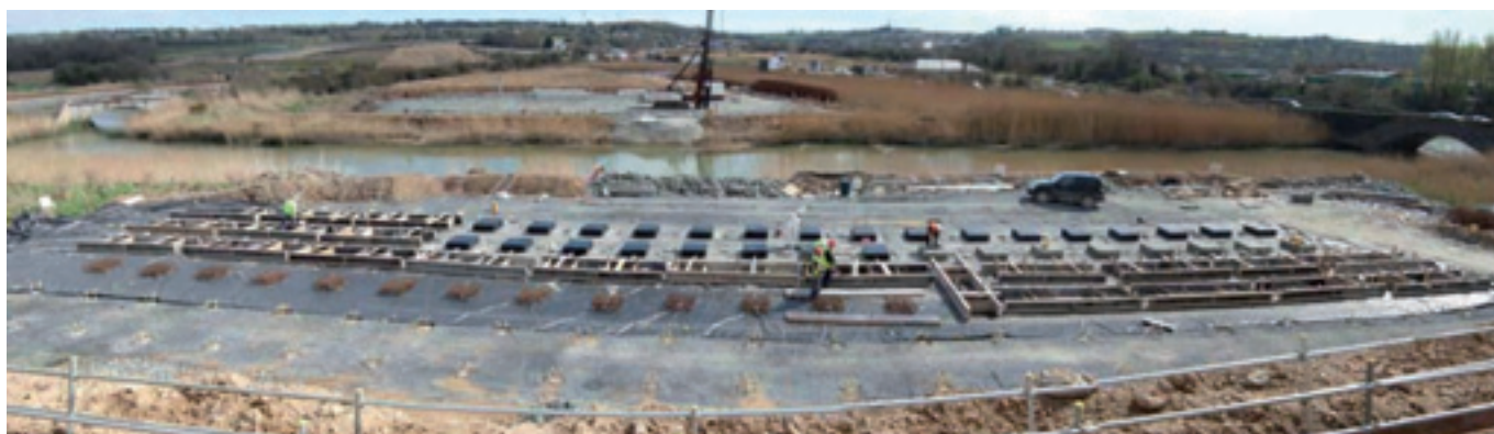
Figura 5. Preparación de un relleno pilotado en la aproximación a una estructura (hormigonado de los encepados en cabeza).
