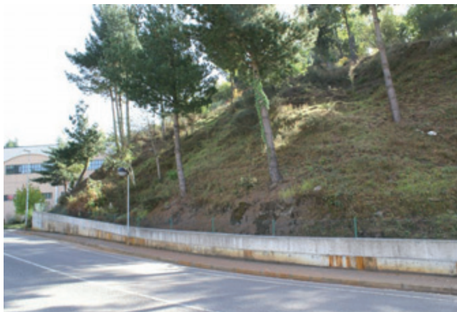
Figura 6. Efectos del drenaje ácido sobre un talud.
