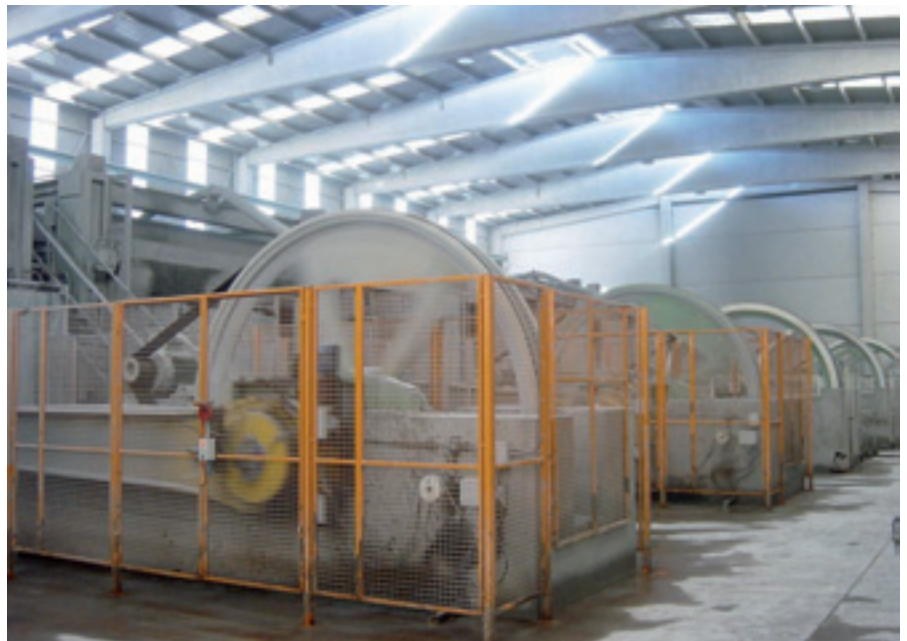
Figura 8. Maquinaria de corte.
