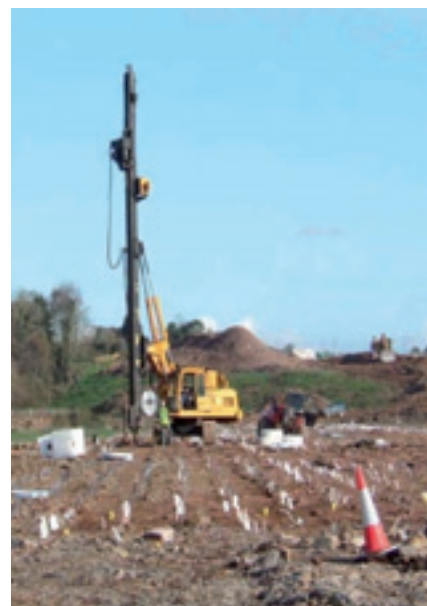
Figura 4. Instalación de mechas drenantes.
