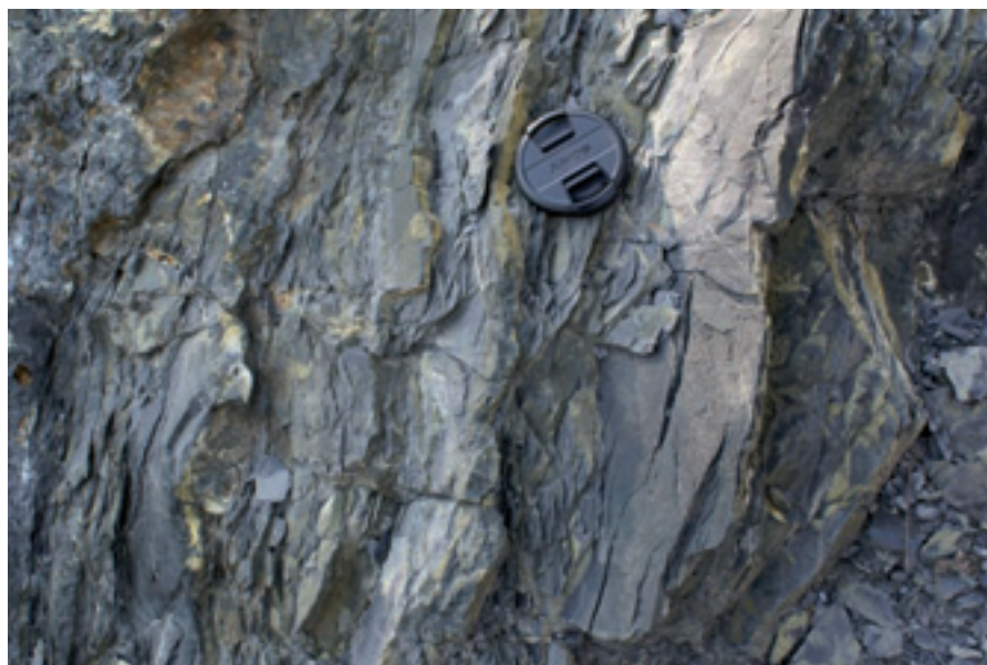
Figura 1. Aspecto de una roca ácido-sulfatada.
