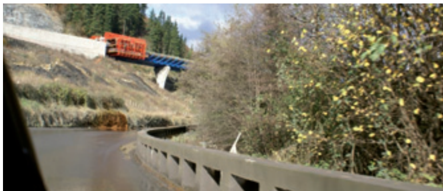
Figura 18. Lixiviación de un relleno de rocas ácido-sulfatadas.
