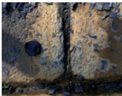
Figura 7. Ataque al hormigón, visualizándose el árido.
