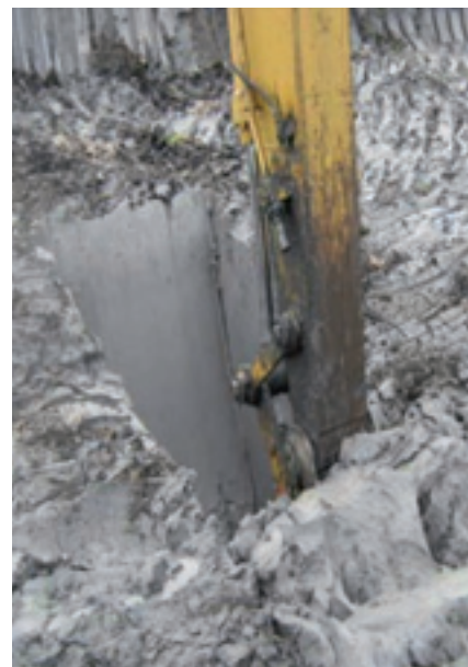
Figura 3. Excavación para la sustitución de limo aluvial gris blando.
